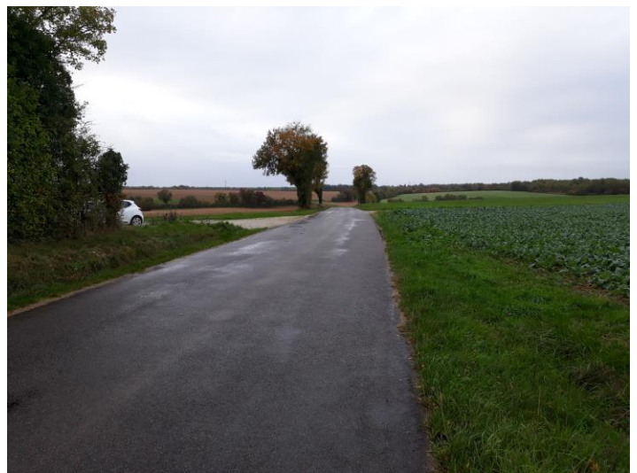
Vue de l'accès depuis la RD 45 sens PR décroissant
