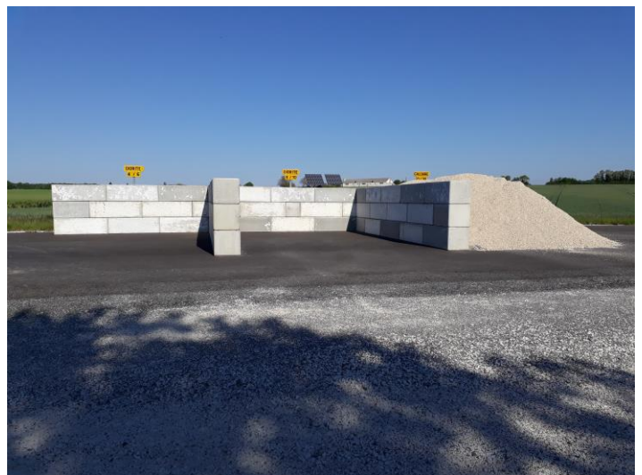
3 cases à matériaux sur plateforme en enrobé
